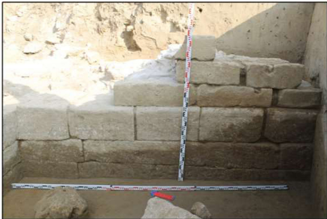
Рис. 10. Рубасский оборонительный комплекс сер. VI в. Стена №2. Западный фасад. Южный участок. Вид с запада. Фото 2017 г.
