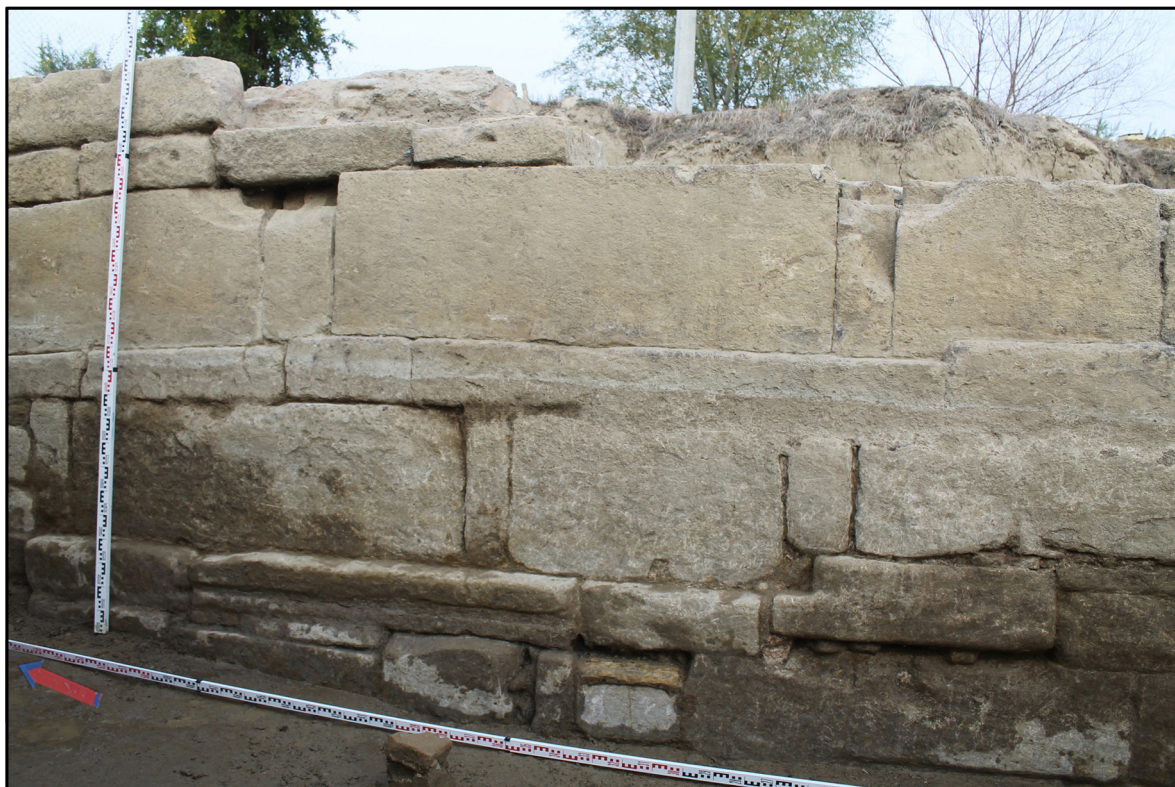
Рис. 7. Рубаский оборонительный комплекс сер. VI в. Стена №2. Западный фасад. Центральный участок. Вид с запада. Фото 2017 г.
