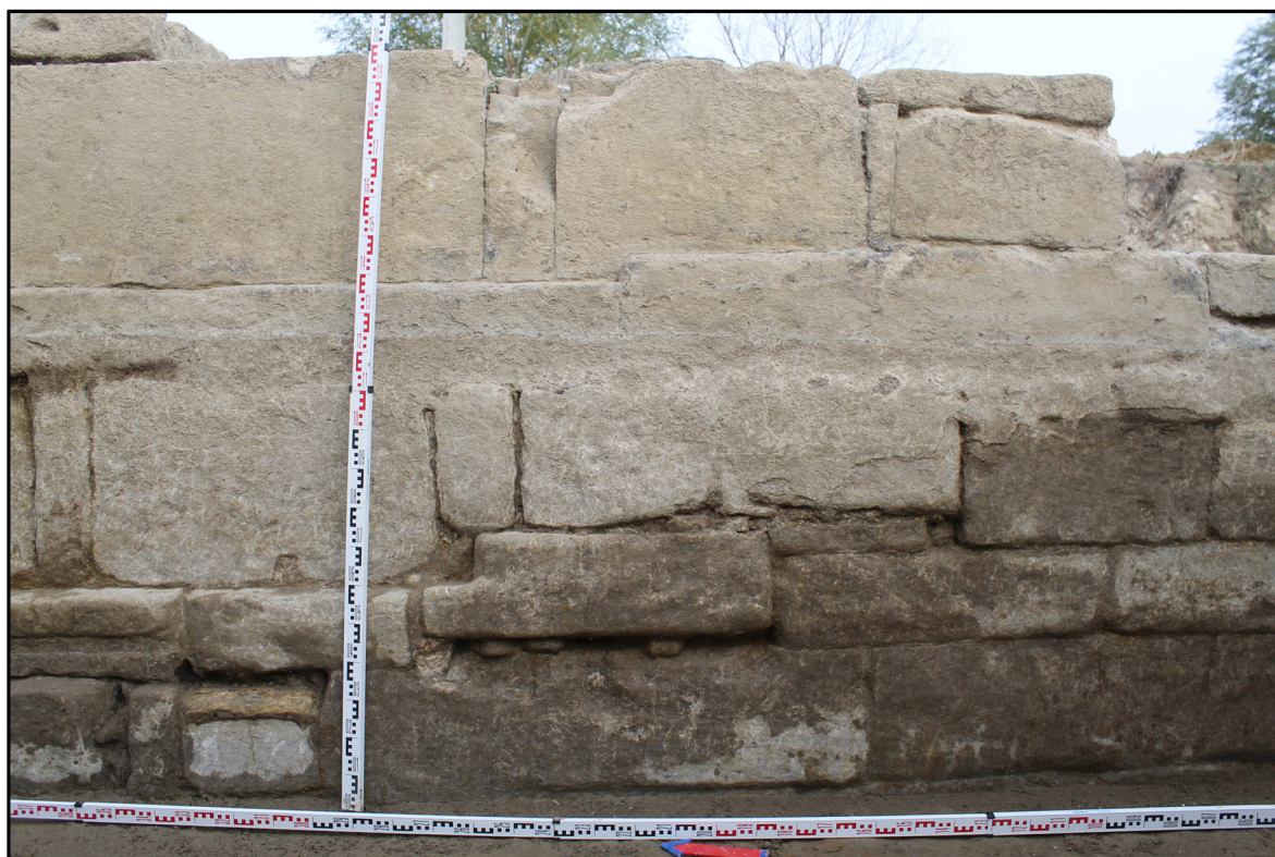
Рис. 8. Рубаский оборонительный комплекс сер. VI в. Стена №2. Западный фасад. Центральный участок. Вид с запада. Фото 2017 г.
