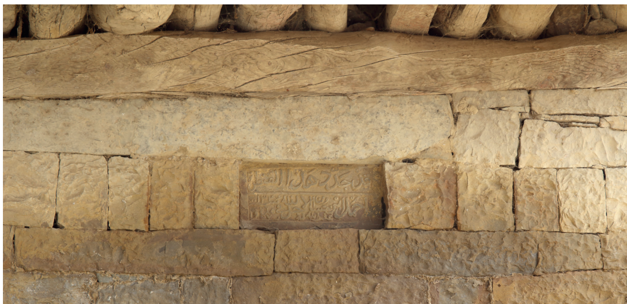
Илл. 20. Плита с сообщением о реставрации кункинского моста, вделанная в опору сооружения
