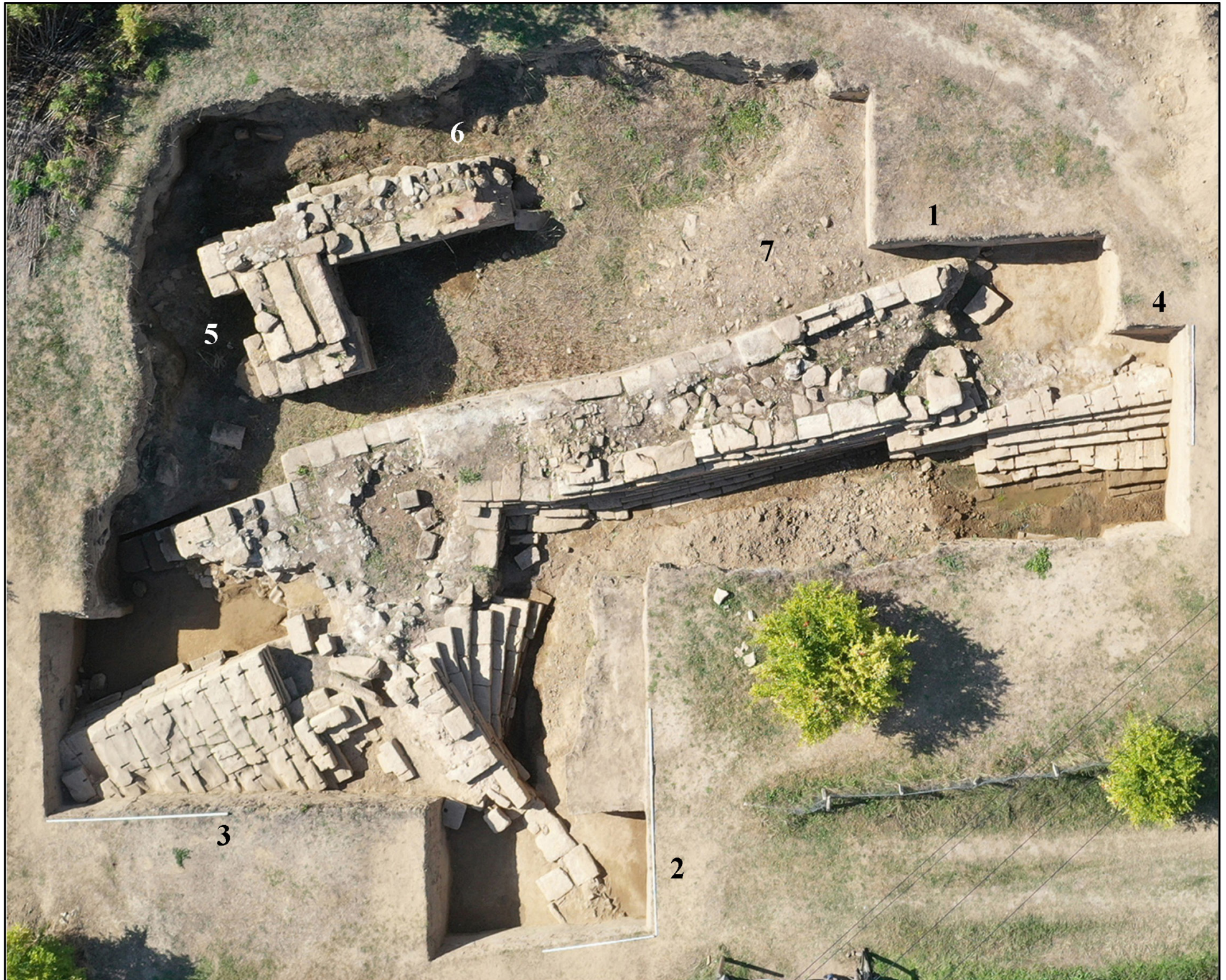
Рис. 1. Монументальное архитектурное сооружение на р. Рубас. 1 – стена № 2; 2 – стена № 3; 3 – сооружение № 5 (платформа); 4 – сооружение № 6 (пристройка); 5 – сооружение арочной конструкции; 6 – стена № 1; 7 – отложения селя. Вид с востока. Аэрофотосъемка беспилотным летательным аппаратом 2022 г.
