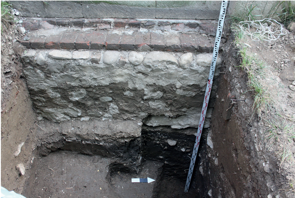
Рис. 5. г. Хасавюрт. Знаменская церковь. Шурф 1. Западный борт. Вид с В Fig. 5. Khasavyurt. Church of Our Lady of the Sign. Shaft 1. West side. View from B
