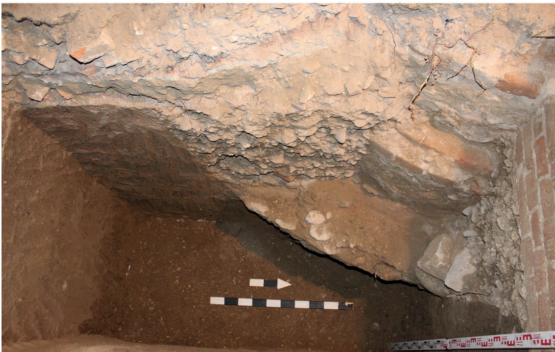
Рис. 12. г. Хасавюрт. Знаменская церковь. Шурф 2. Конструктивный элемент расширения подошвы фундамента и материковый галечно-гравийный слой. Вид сверху
