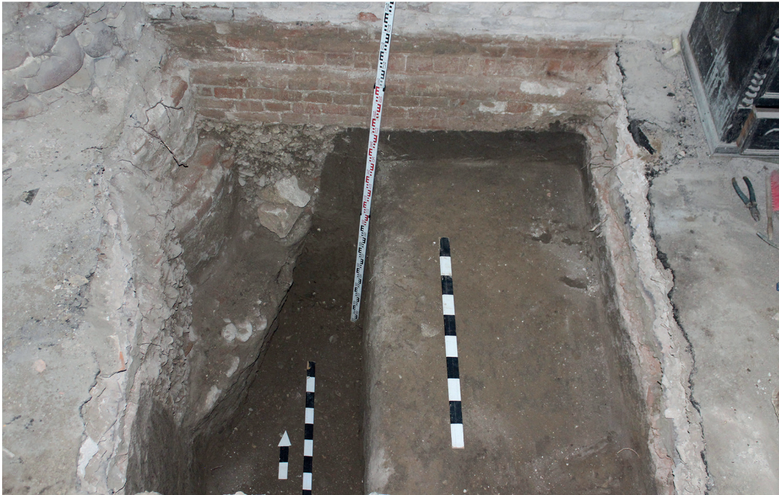
Рис. 11. г. Хасавюрт. Знаменская церковь. Шурф 2. Конструктивный элемент расширения подошвы фундамента и материковый галечно-гравийный слой. Вид с Ю
