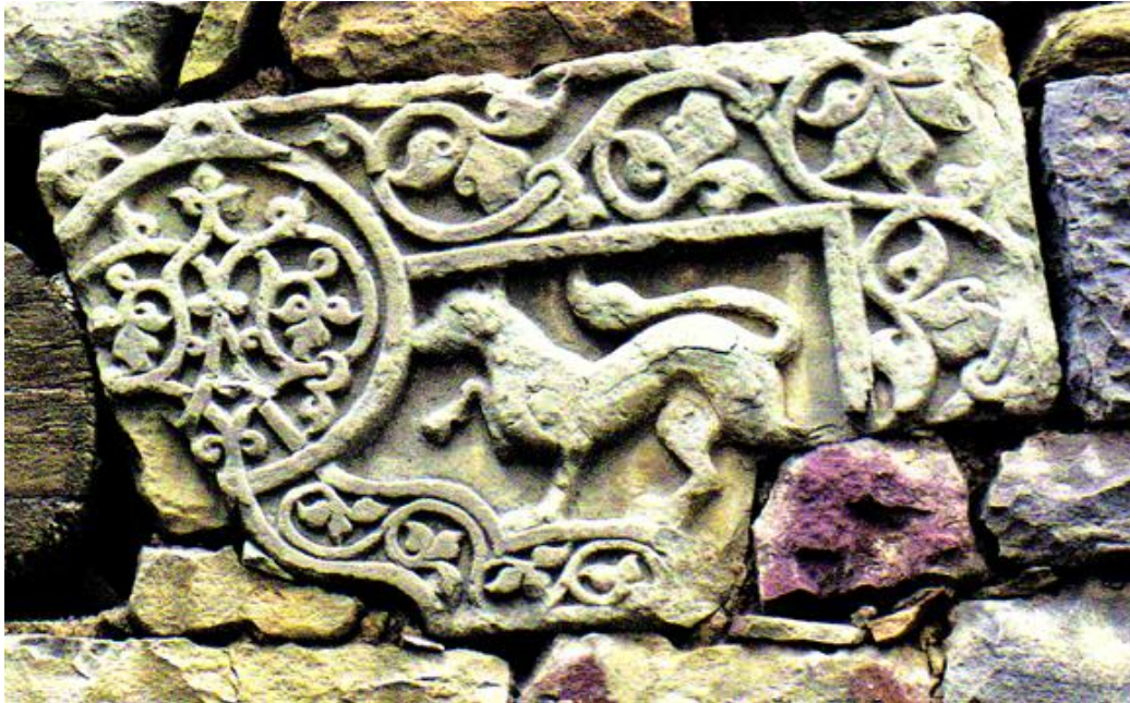
Рис. 7. Каменный рельеф – архитектурная деталь с изображением идущего барса в кладке стены западного фасада жилого дома З. Чамсутиновой в нижнем квартале с. Кубачи. XIV–XV вв.
